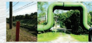
Dämme und Zäune Die Fernwärmeleitung
