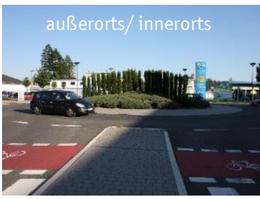
Seitenraumführung Radverkehr, Vorrang Fuß- und Radverkehr an Knotenarmen
