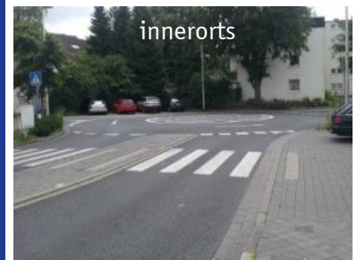
Mischverkehrsführung Radverkehr, FGÜ an Knotenarm
